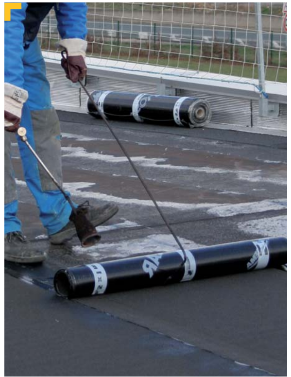
Applicazione di Soprasolar mono®, finitura con autoprotezione
