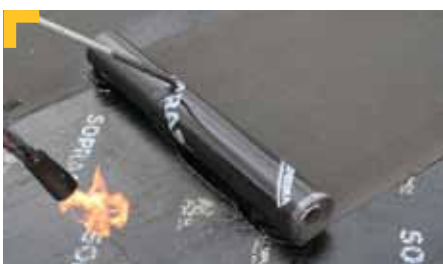
Posa del secondo strato impermeabile, Soprasolar Cap® (dimensione 6 m x 1 m). Applicazione a giunti sfalsati di 25 cm.
