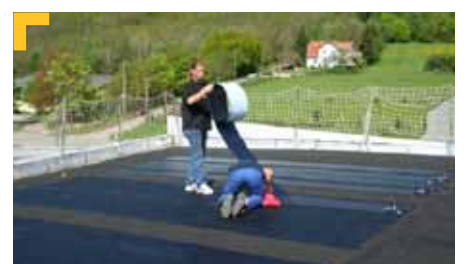
Incollaggio cella, successiva applicazione di un cordone di Sopramastic 200 in testata.
