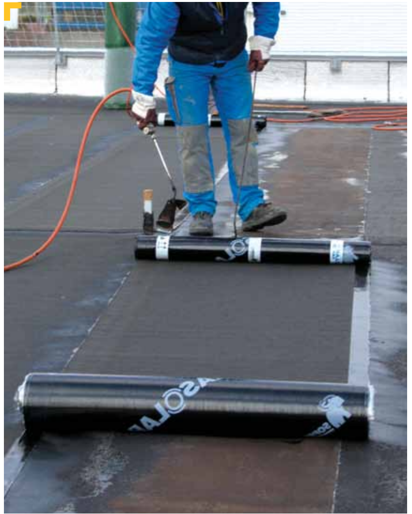
Applicazione di Soprasolar Cap®, 2° strato silicato autoprotetto
