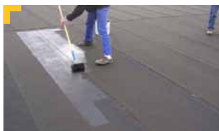
Applicazione del primer, Soprasolar Prim® , sul tracciamento + 5 cm per ogni cella.
